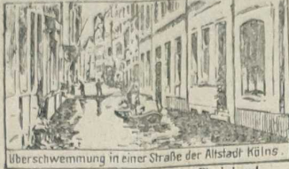
Überschwemmung in einer Straße der Altstadt Kölns.
